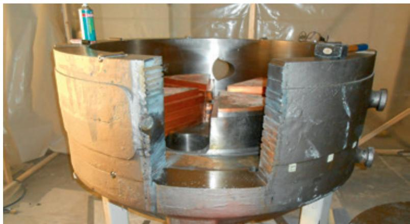
Abb. 3: Zyklotron 1 – Demontage aktivierter Bereiche
